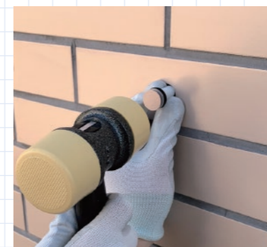
打ち込まれたアンカーに 軽く挿入し
